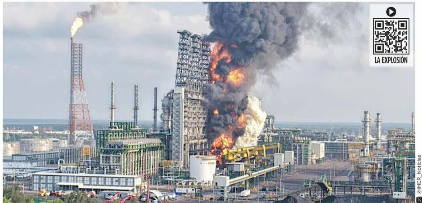
La explosión en la refinera de Dos Bocas ocurrió en una bodega de coque y oficialmente no se reportaron lesionados.
